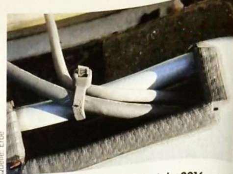
16 Diese PV-Leitung aus dem Jahr 2016 wurde der direkten Sonneneinstrahlung ausgesetzt
