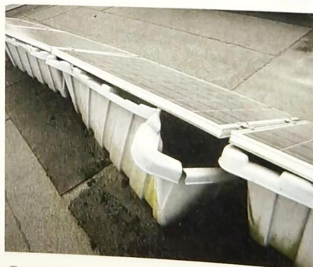
6 Defektes Kunststofftragsystem
