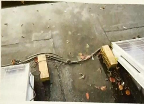
14 Mangelhafte Leitungsverlegung
