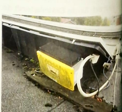
10 Befestigung und Kabelführung dieses Wechselrichters sind mangelhaft
