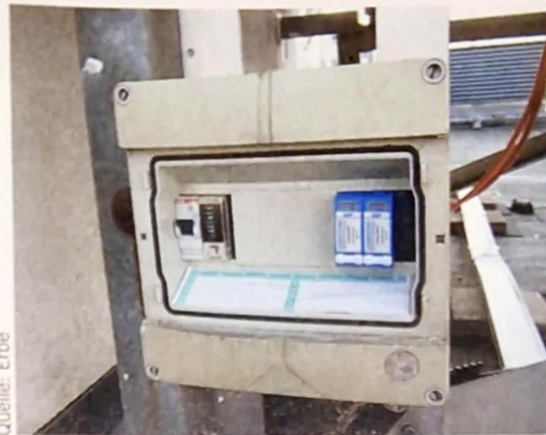
13 Bei diesem Gehäuse im Dachbereich fehlt das Klappfenster
