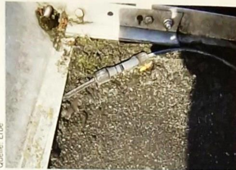
15 Steckverbinder und DC-Leitung sind ungeschützt auf der brennbaren Dachhaut verlegt
